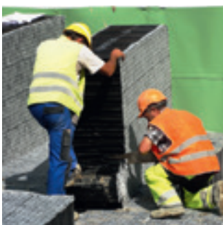
Einfaches Zuschneiden mit Hand- oder Motorsäge
