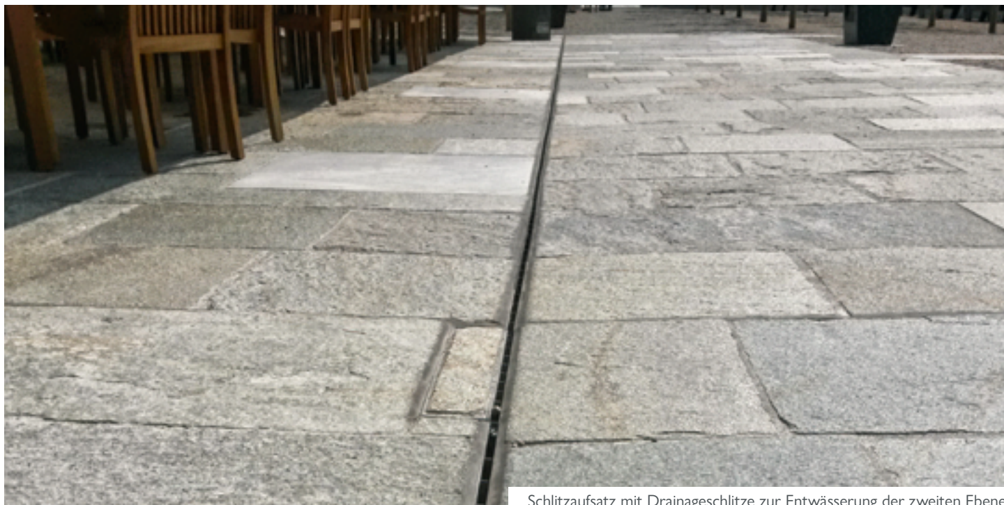
Schlitzaufsatz mit Drainageschlitze zur Entwässerung der zweiten Ebene
