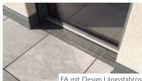
Schlitzaufsatz mit Drainageschlitze zur Entwässerung der zweiten Ebene
