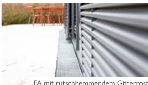
Schlitzaufsatz mit Drainageschlitze zur Entwässerung der zweiten Ebene
